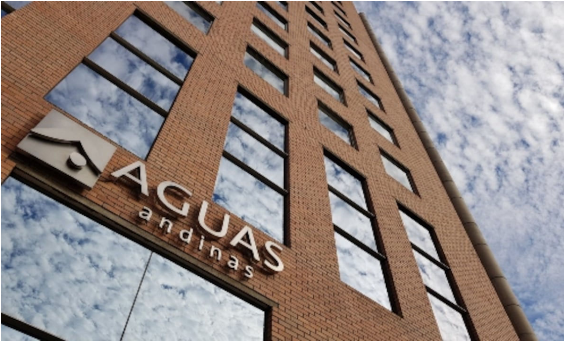
Edificio institucional de Aguas Andinas.
