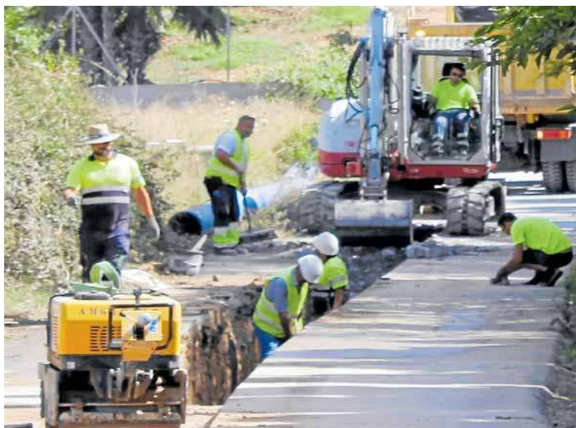
Trabajos de construcción de la tubería que conecta Málaga y Alhaurín de la Torre. J. R. C.
